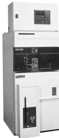
Рис. 4: Пример применения ЭМС: SM6 панель среднего напряжения, содержащая токовый выключатель, предназначенный для прерывания мощности (сотни ампер и десятки киловатт), и прибор СЕПАМ- программируемое средство управления, мониторинга и защиты. Полная сборка должна оставаться действующей при любых обстоятельствах.
